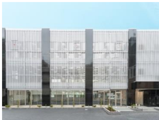
東東京支社 葛飾区亀有
